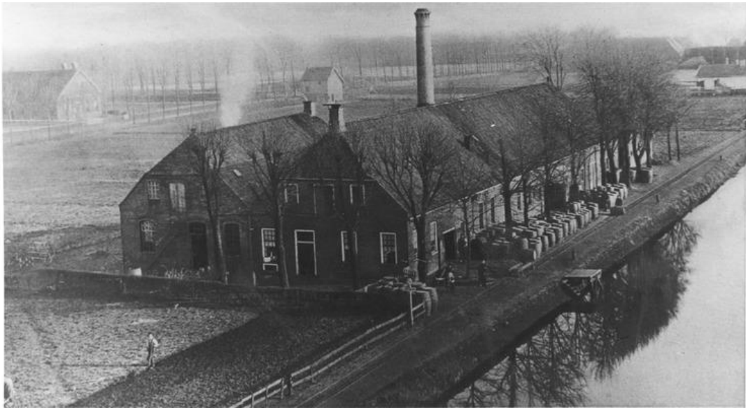
Gist- en spiritusfabriek van Pieter van Calcar aan het Heveapad, gesticht in 1839, met rechts daarvan het Kieldiep. Op de achtergrond links de Kerkstraat met het 'diaconiehuis', en het in 1867 gebouwde gemeentelijke tolhuisje (1900).
